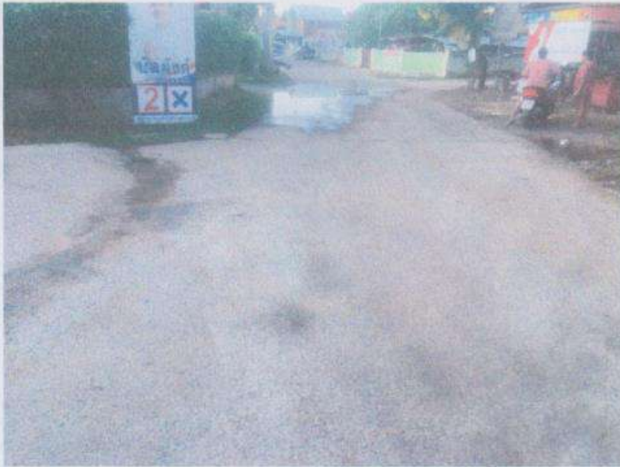
ภาพถ่ายก่อนดำเนินการ
